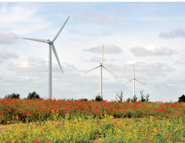
Windkraftanlagen im ländlichen Raum
